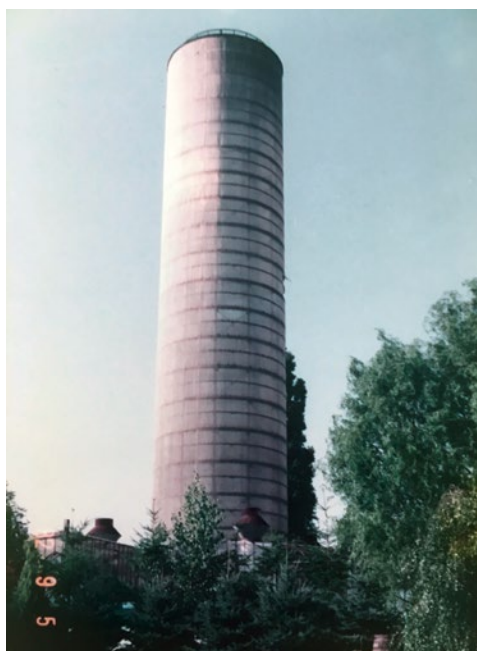
Abb. 3: Ruthner-Turm – verpflanzt vom Ufer der Donau an die Flöth
