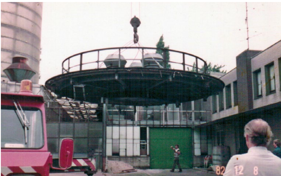
Abb. 9: Abbau des Gewächshausturms – Das Dach kommt unten an
