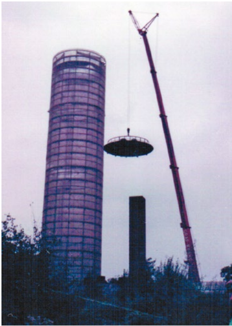
Abb. 8: Abbau des Gewächshausturms – Der Kran hebt das Dach ab
