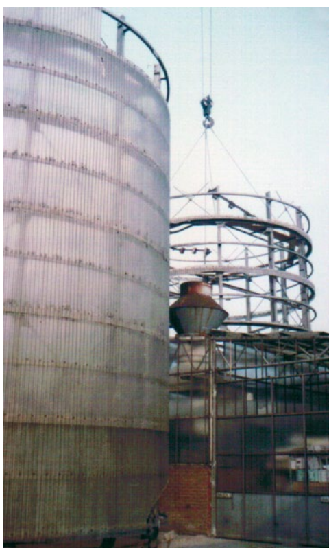
Abb. 11 (links): Abbau des Gewächshausturms – Das vorletzte Segment wird heruntergeholt
