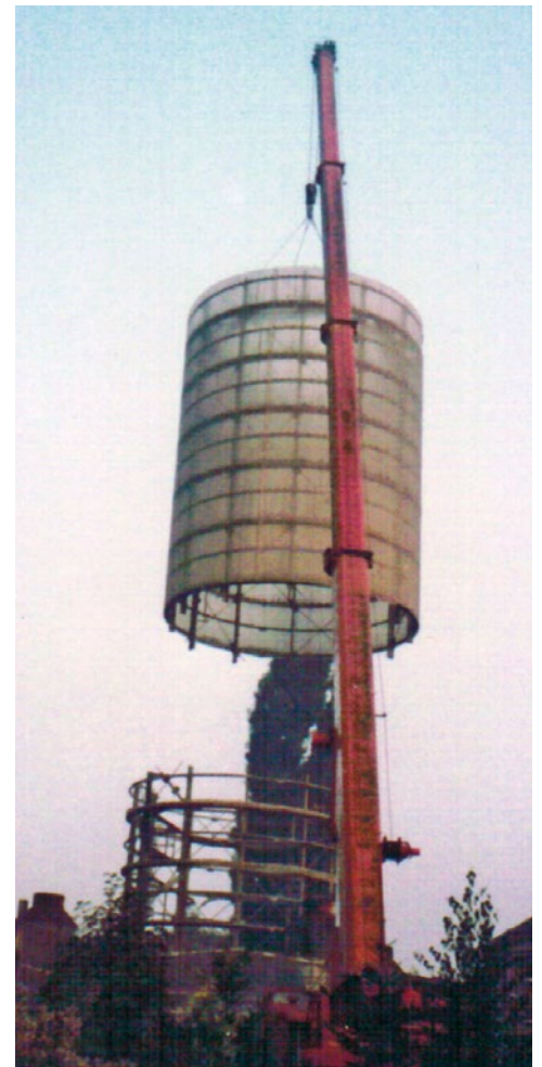
Abb. 10: Abbau des Gewächshausturms – Einzelne Segmente werden herabgelassen
